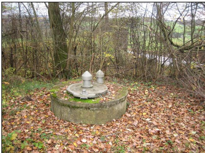
Die als Grundwassermessstelle genutzte Erkundungsbohrung schließt mit einem runden Betonschacht ca. 40 cm über dem Geländeniveau ab.
