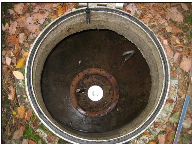
Die Oberkante der Verrohrung liegt ca. 20 cm über dem Niveau des Schachtbodens. Zu sehen ist das Stahlsperrohr und die darin liegende, abgedeckte PVC-Verrohrung.
