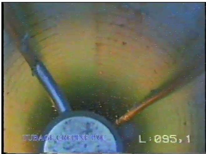
Auch im unteren Teil der Filterstrecke wurde eine zu den Bereichen oberhalb kaum veränderte Situation vorgefunden. Nur bereichsweise deuteten sich leichte Ockeraufwüchse an Filterschlitzten an.
