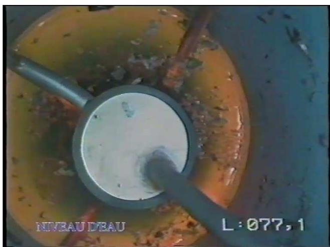
Der Grundwasserspiegel wurde bei der Befahrung in ca. 77 m Tiefe angetroffen. Damit liegen die oberen ca. 10 bis 11 m der Filterstrecke über dem Grundwasserspiegel.
