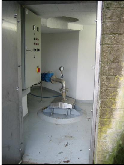
Der Brunnen ist zentral in der engen Brunnenstube positioniert und liegt in gerader Linie zum Zugang. Über dem Brunnenkopf ist die Deckenöffnung für Kranarbeiten zu erkennen.
