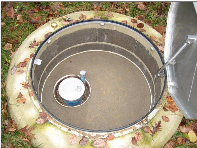
Der flache Schacht ist außermittig über der Bohrung positioniert. Die Messstelle wurde ursprünglich als Erkundungsbohrung zur Trinkwassererschließung errichtet. Im näheren Umfeld befinden sich mehrere weitere Bohrungen.
