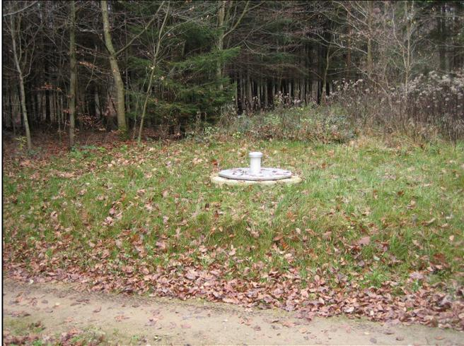
Die Grundwassermessstelle schließt etwa in Geländehöhe in einem runden Betonschacht ab, der Anfang 2008 neu errichtet wurde. Vorher lag der Bohrungsabschluss in einer Erdaufschüttung.
