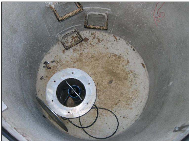
Die Bohrung liegt randlich im Schacht. Im oberen Bereich ist die PVC-Verrohrung von einem Sperrrohr aus Edelstahl ummantelt. Der Einstieg in den Schacht wird durch Tritteisen erleichtert.
