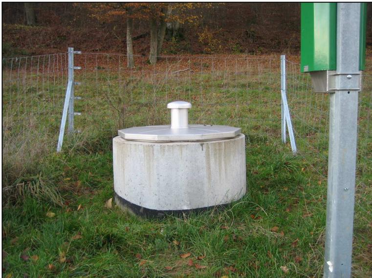
Die Messstelle schließt in einem runden Schacht über Flur ab, der mittels eines Schachtdeckels mit Dunstthut verschlossen ist.
