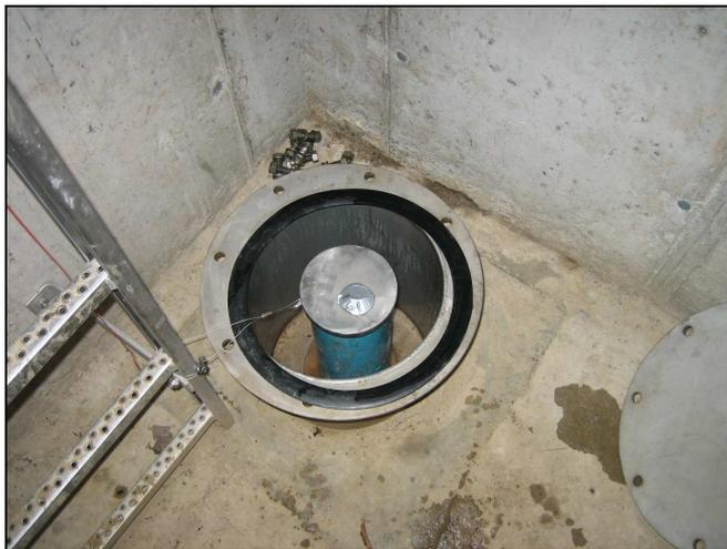
Die Bohrung ist mit einer PVC-Verrohrung DN 150 ausgebaut, die im oberen Teil von einem Edelstahlsperrrohr mit einem Durchmesser von 320 mm ummantelt wird. In der Rohrtour sind zwei Messsonden zur Erhebung von Wasserstand, Wassertemperatur und Leitfähigkeit abgehängt.
