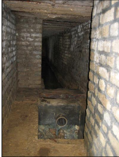
Der Stollen der Quelle 1 ist gemauert. Das am Ende aus dem Fels zufließende Quellwasser wird über die Stollensohle nach vorne geführt und in eine Rohrleitung eingespeist.
