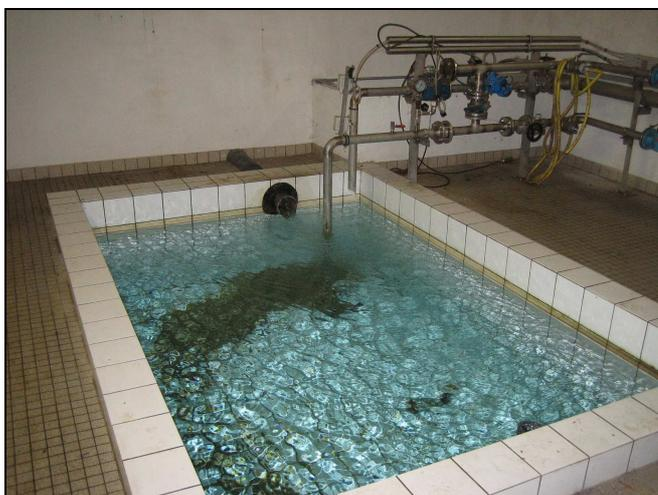
In der Pumpstation fließt das Quellwasser in ein gefliestes Vorlagebecken, das auch als Sandfang dient. Über eine Rohrleitung wird das Wasser in den Vorfluter geleitet, da die Quelle nicht mehr der Trinkwasserversorgung genutzt wird.
