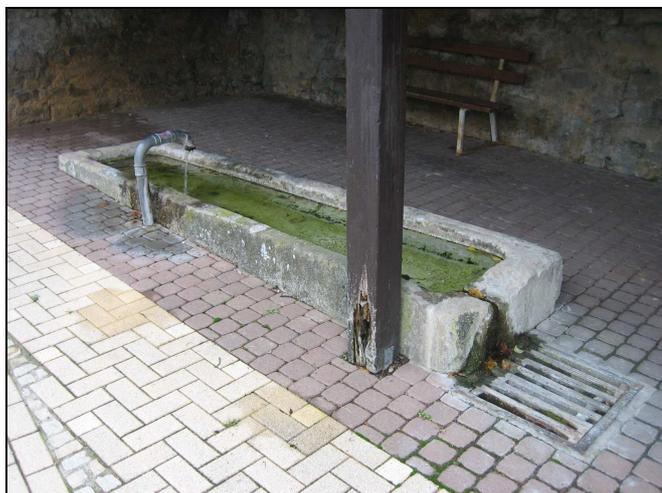
Das Quellwasser tritt an einem bogenförmigen Rohr zutage und wird in ein Becken geleitet. Der Überlauf wird in den Kanal geführt. Angaben zur Lage und Art der eigentlichen Wasserefassung sind nicht bekannt.
