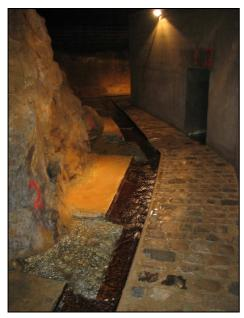
Im hinteren Teil der Fassung wird das aus dem Fels zuströmende Quellwasser in einer Rinne am Boden gesammelt und zur Speicherkammer geführt.
