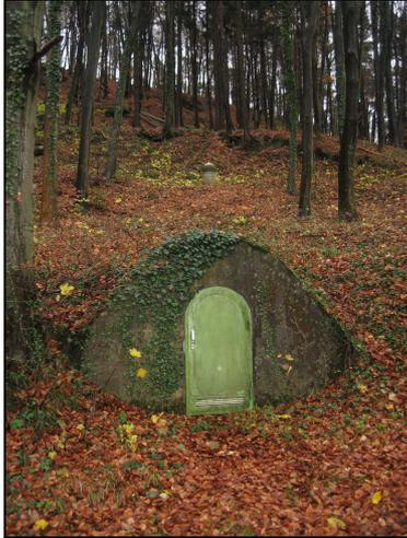
Die Quelfassung besteht aus einem Stollen, der seitlich in den Hang führt. Die Quelle fasst Wasser aus den Hangschuttmassen des Luxemburger Sandsteins.
