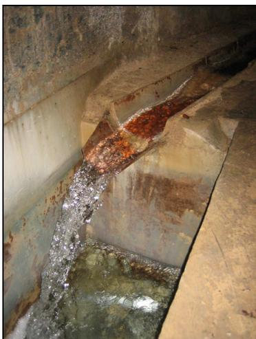
Am Ende der Rinne wird das Wasser in ein kleines Sandfangbecken geleitet. Am dortigen Überfall kann eine händige Schüttungsmessung über Auslitern erfolgen.
