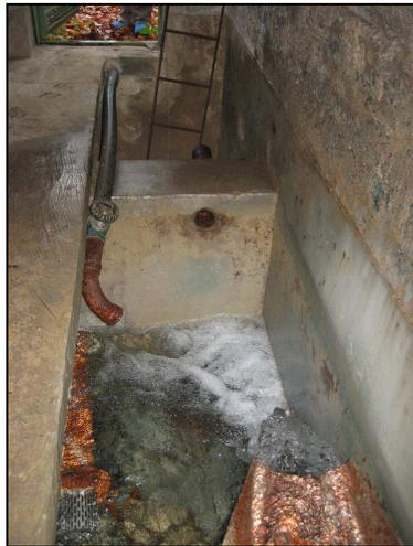
Vom Sandfangbecken führt eine Rohrleitung zum Hochbehälter. Bedarfsweise kann überschüssiges Wasser über einen Überlauf der Vorflut zugeleitet werden.
