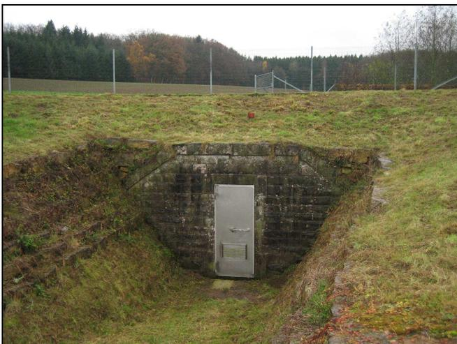
Die separate Kammer, in der sich der Sandfang befindet, ist durch die Abgrabung unterhalb des Wegs ebenerdig über eine Tür begehbar.
