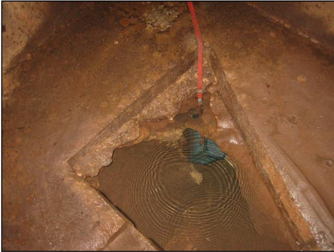
Der Wasserzutritt erfolgt aus dem offenen Fels über eine trapezförmige Öffnung in der betonierten Bodenplatte der Quellkammer.
