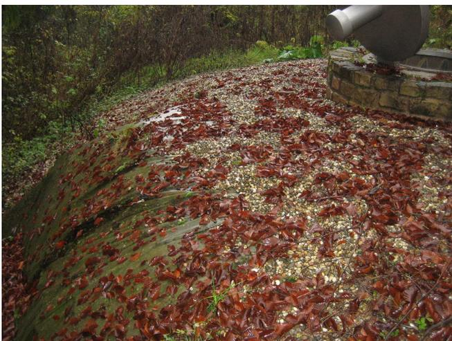
Das Sammelbauwerk liegt in einer Aufschüttung, die mit einer mit Kies beschwerten Schutzplane abgedeckt ist.
