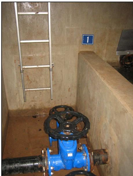
Der Zugang zur Sammelkammer ist von oben über eine Leiter möglich. Im Vordergrund ist die Schiebervorrichtung der abgehenden Leitung zu erkennen.
