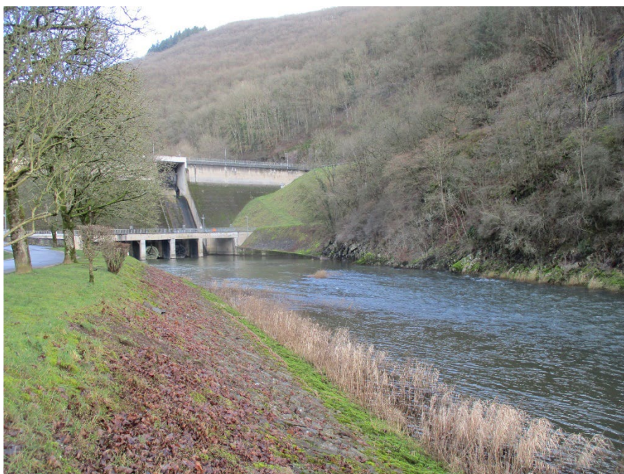
Staumauer am Unterbecken des Pumpspeicherkraftwerks Vianden an der Our | Mögliche Belastungen durch Schwall und Sunk können durch technische und betriebliche Maßnahmen abgemildert werden.
