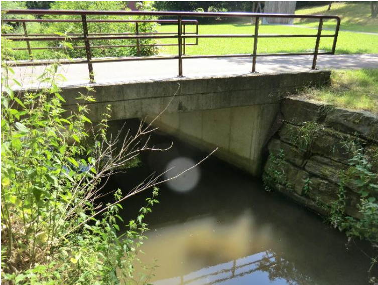
Durchlass; Ufer unterbrochen
