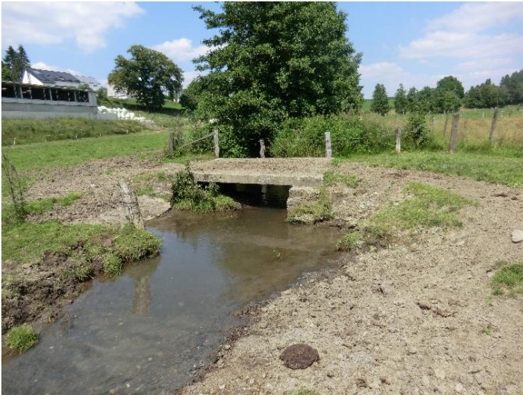
Durchlass; Ufer unterbrochen
