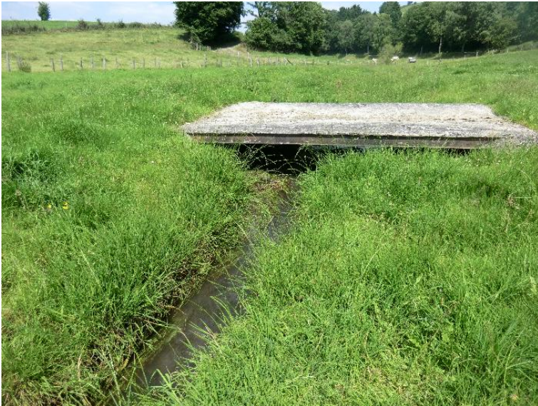
Durchlass; Ufer unterbrochen
