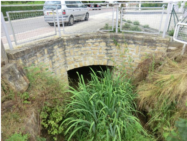
Durchlass; Ufer unterbrochen
