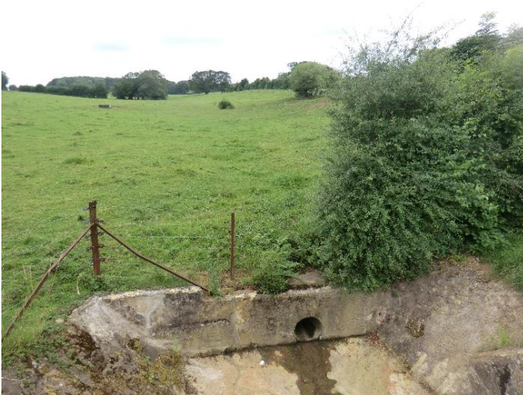
beginn verrohrung trockenb
