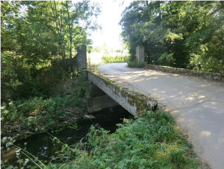
Durchlass; Ufer unterbrochen
