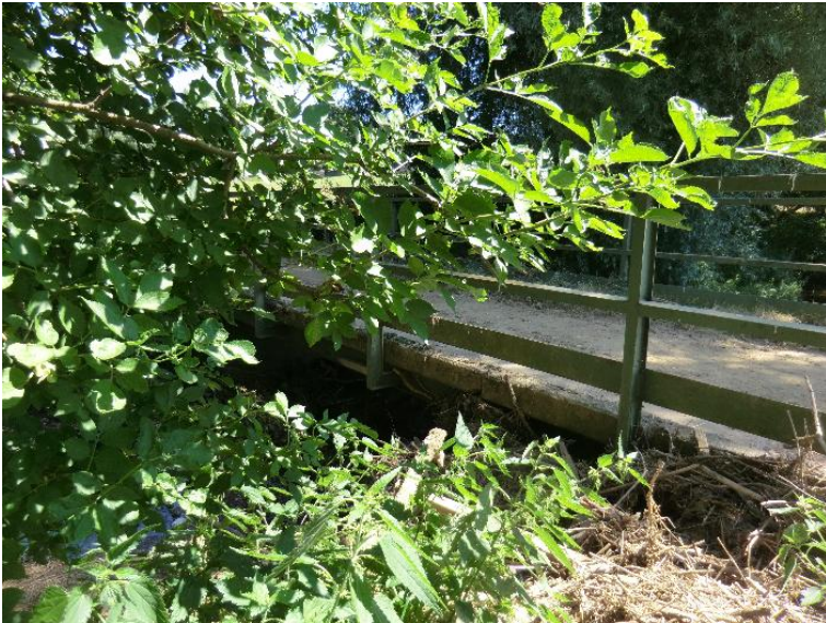
Durchlass; Ufer unterbrochen
