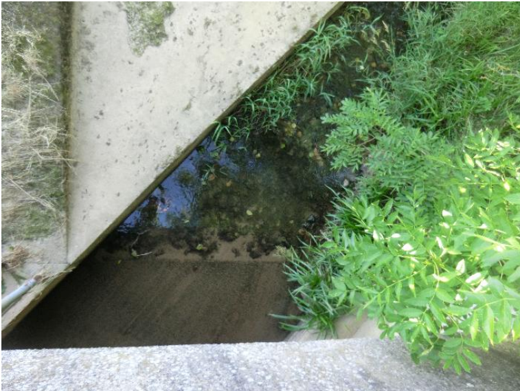
Durchlass; Ufer unterbrochen
