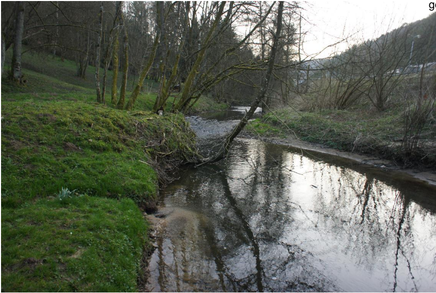
Zulauf Nebengewässer - Wurzelflächen
