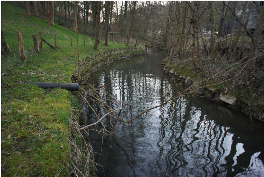
Uferverbau Steinsatz unverfugt
