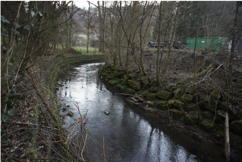
Uferbefestigung durch Steinbloecke - Uferverbau Steinsatz unverfugt
