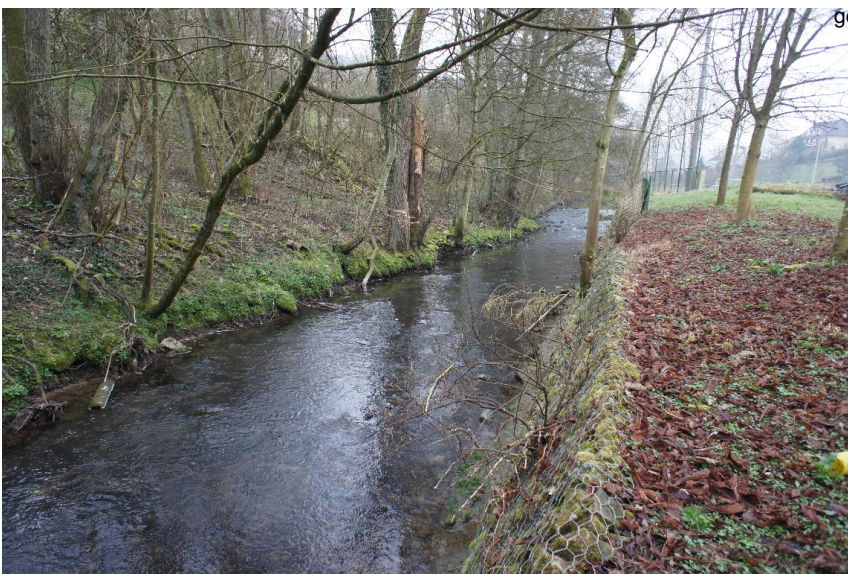
Kastenprofil; einseitiges - Uferverbau Steinsatz unverfugt
