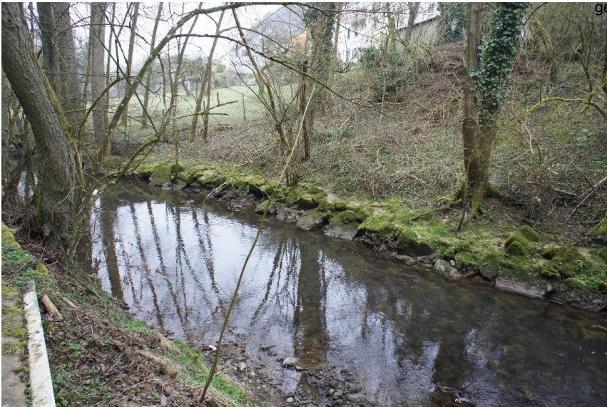
Uferbefestigung durch Steinblöcke
