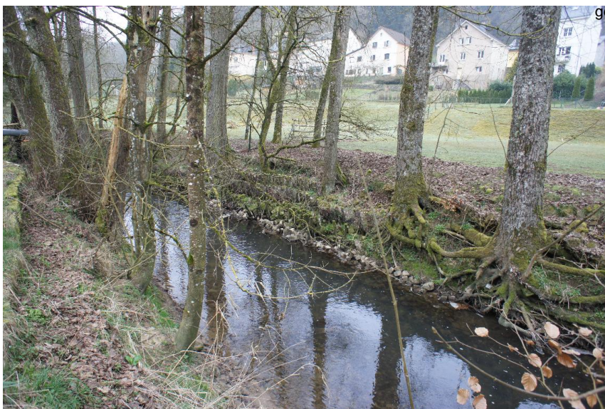
Holzverbau; verfallener - Steinschüttung
