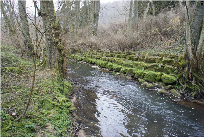
Uferbefestigung durch Steinblöcke - Wurzelflächen
