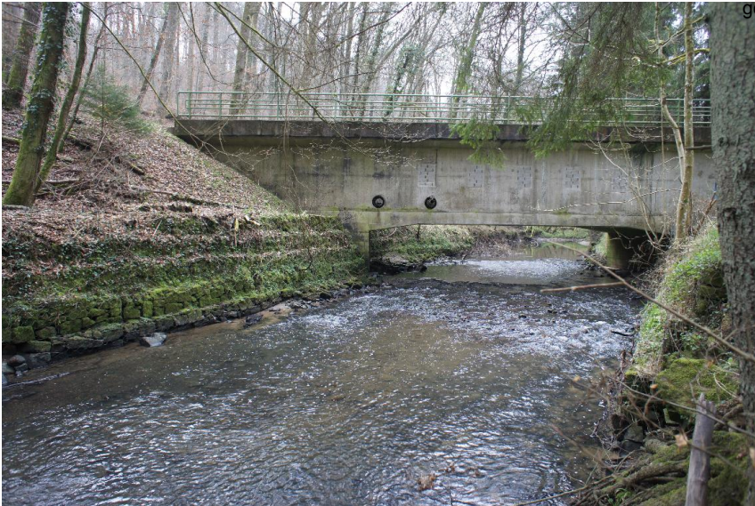
Durchlass; Ufer unterbrochen - Uferverbau Steinsatz unverfugt
