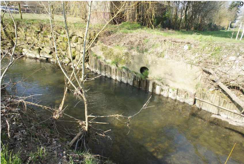
Einleitung - Spundwand - Uferbefestigung durch Steinbloecke
