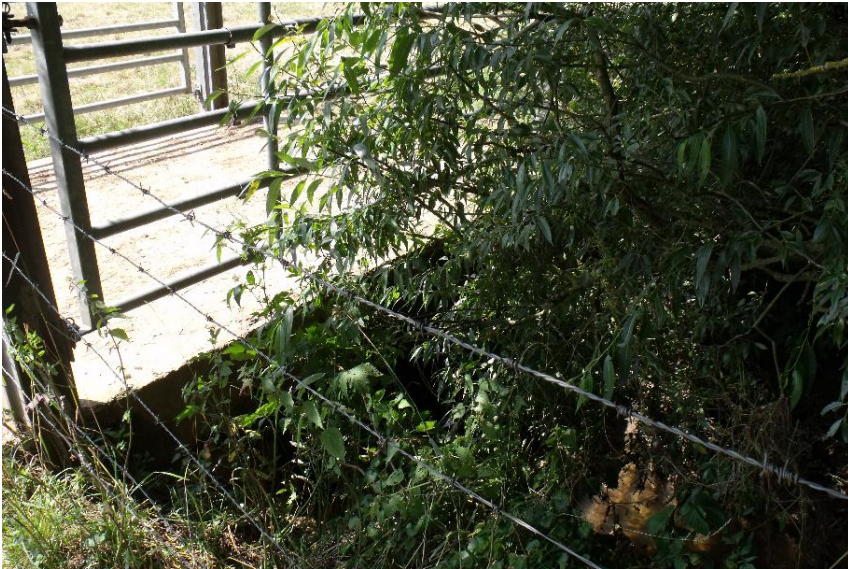
Durchlass; Ufer unterbrochen
