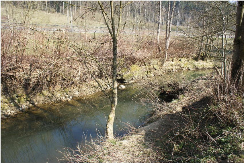
Steinschüttung, punktuell - Uferverbau mit Steinblöcken
