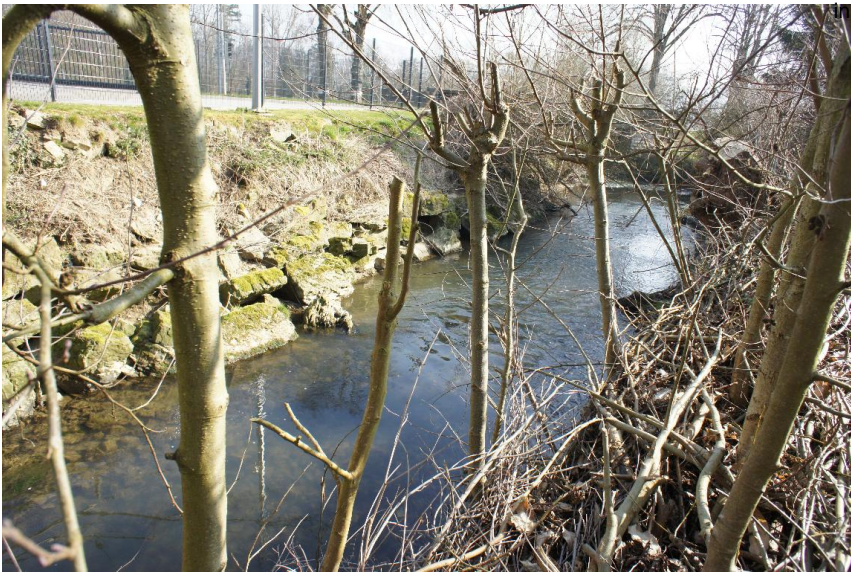
Uferbefestigung durch Steinblöcke - Lebendverbau
