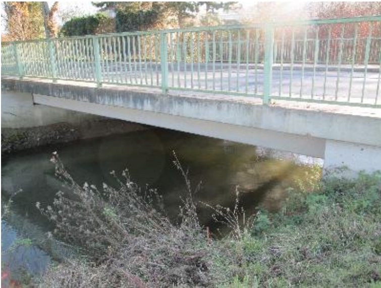
Durchlass; Ufer unterbrochen
