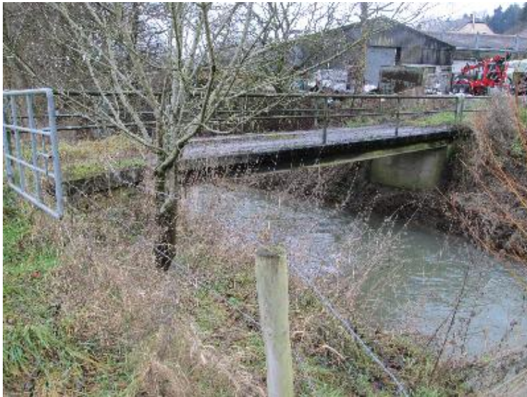
Durchlass; Ufer unterbrochen
