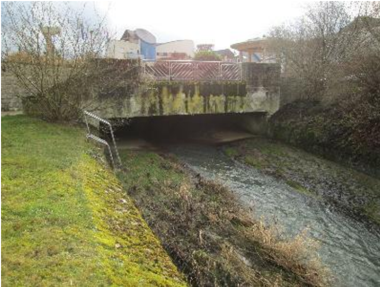
verrohrt bzw. ueberdeckt
