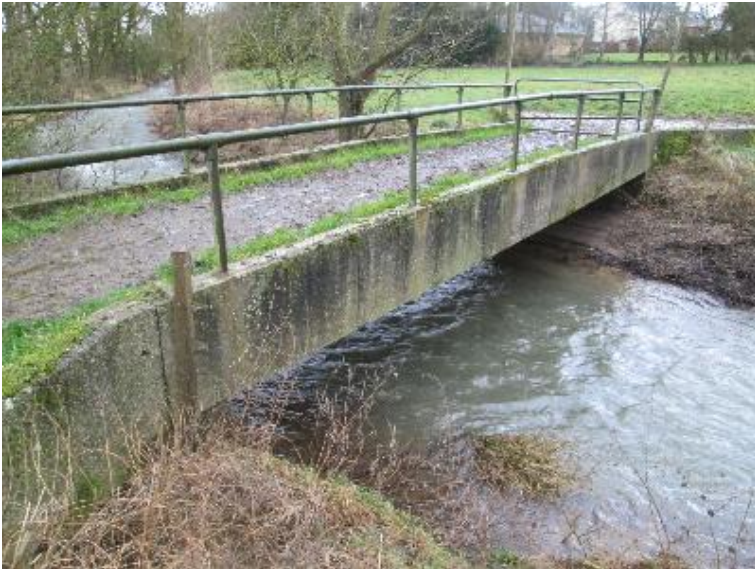
Durchlass; Ufer unterbrochen
