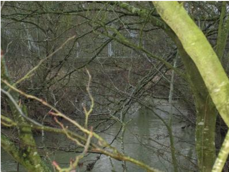
Durchlass; Ufer unterbrochen
