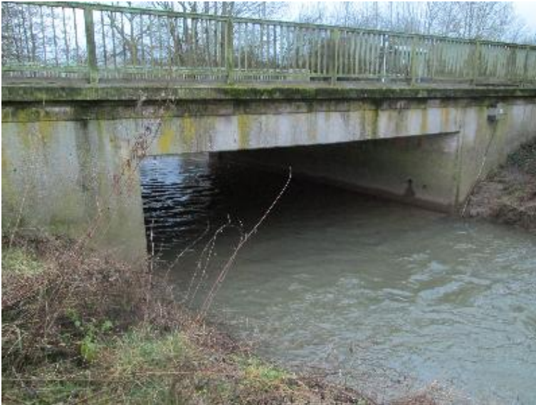
Durchlass; Ufer unterbrochen
