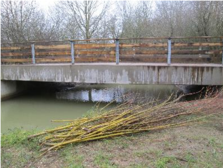
Durchlass; Ufer unterbrochen
