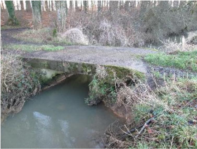
Durchlass; Ufer unterbrochen
