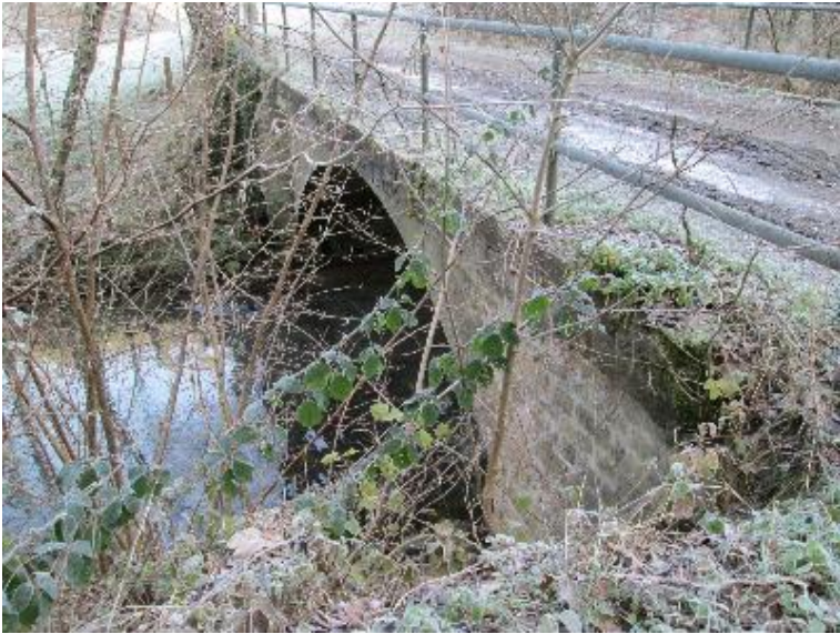
Durchlass; Ufer unterbrochen
