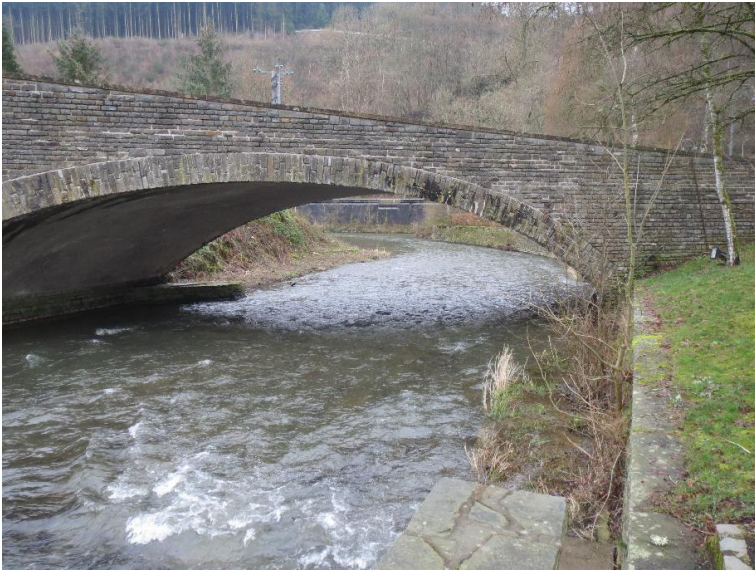
Durchlass; Ufer unterbrochen - Pflaster, verfugt
