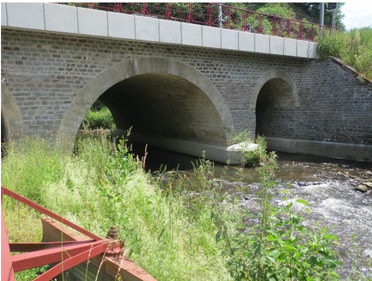
Durchlass; Ufer unterbrochen
