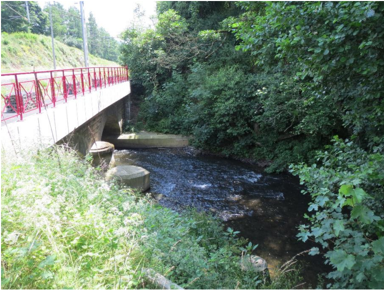
Durchlass; Ufer unterbrochen
