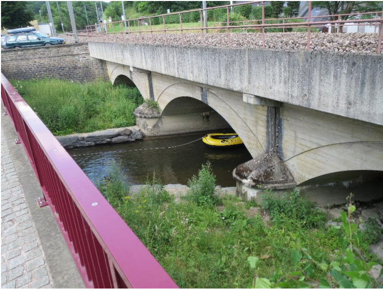
Durchlass; Ufer unterbrochen
