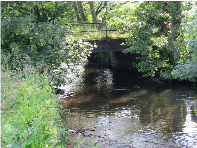
Durchlass; Ufer unterbrochen
