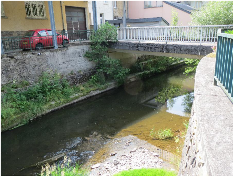
Durchlass; Ufer unterbrochen
