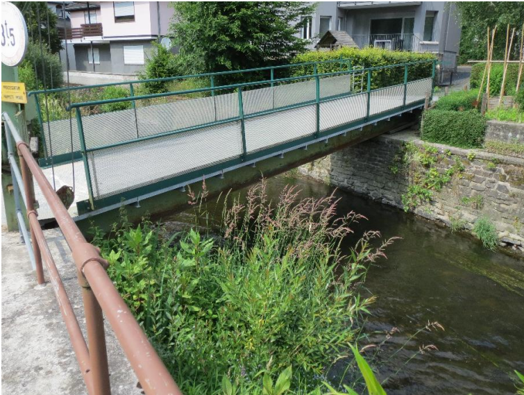
Durchlass; Ufer unterbrochen
