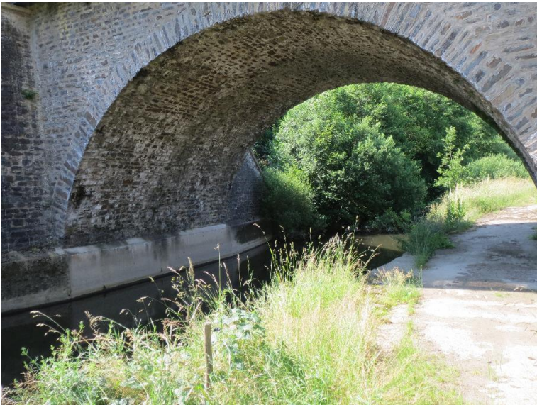
Durchlass; Ufer unterbrochen
