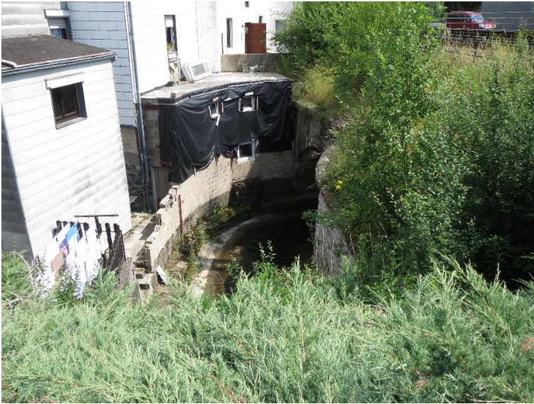
verrohrt bzw. ueberdeckt
