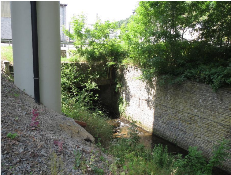
verrohrt bzw. ueberdeckt
